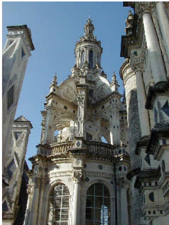
Der Gipfel der Doppeltreppe auf der Terrasse
